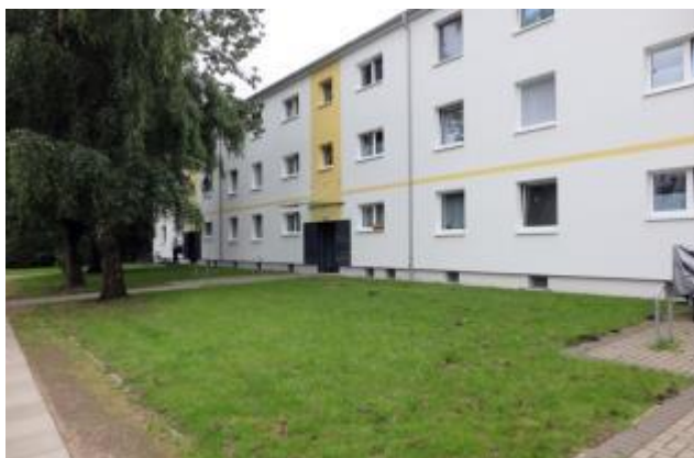
Wohnungsbau in der Sandbek-Siedlung
