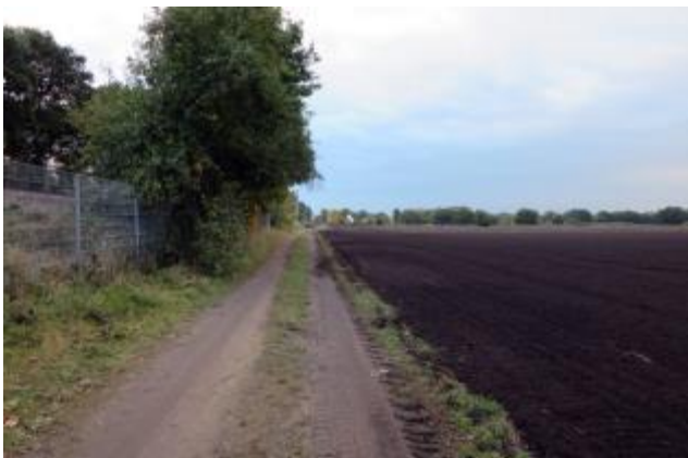
Zustand des Radwegs in Verlängerung der Veloroute 10
