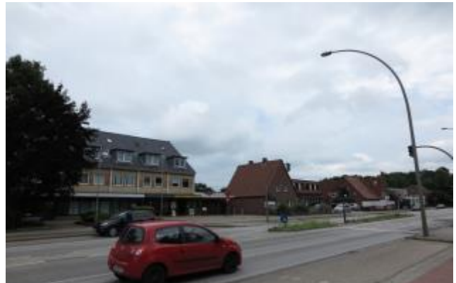
„Altes“ D-Nahversorgungszentrum mit Funktionsverlust
