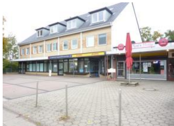
Gewerbenutzungen an der Cuxhavener Straße im „Alten“ D-Nahversorgungszentrum
