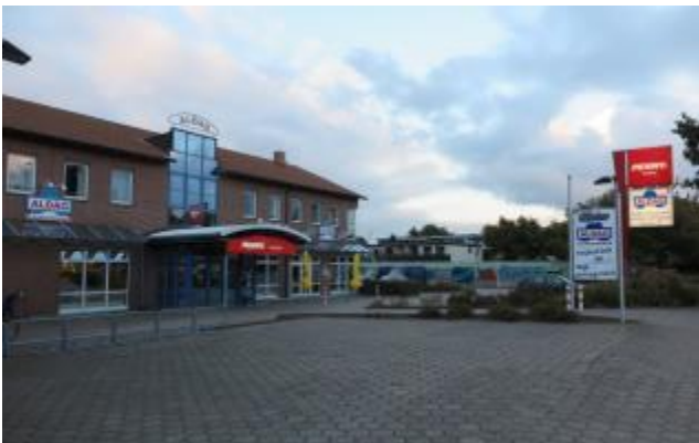
Discount-Markt an der Cuxhavener Straße
